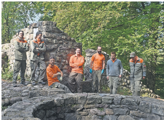
Zivilschützer wurden zur Renovation der Burg Wulp geschickt.
